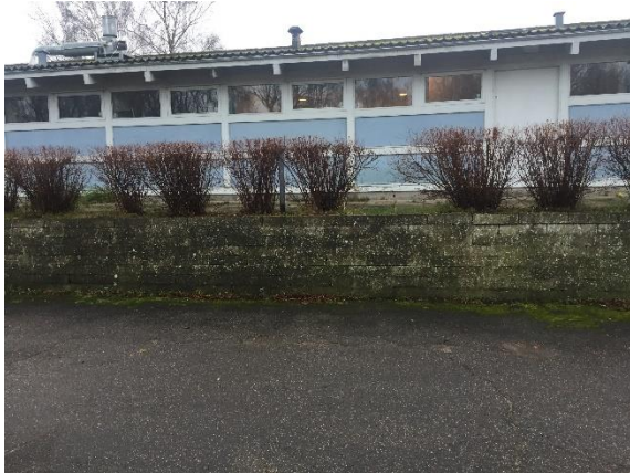
Støttemuren som deler delområde A
